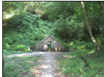
Fig. 10 : La fontana Nizzola, nascosta nel verde, sulla strada che porta a San Costantino.
